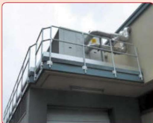
116 • Esempio di parapetto montato su edificio
